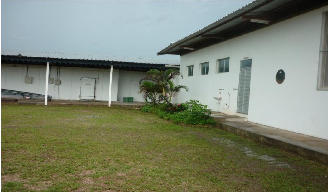
. Figura 25 - Galpão da agroindústria.
